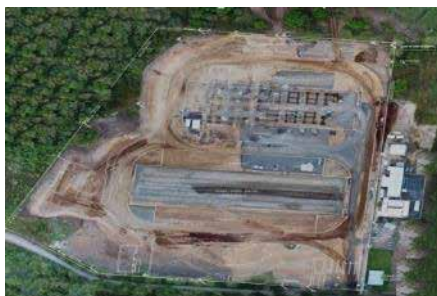
Avance de la construcción de la infraestructura del Mercado de Chorotega. PIMA 2017.
