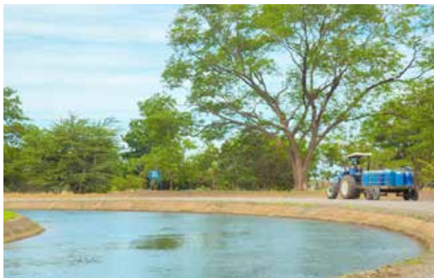
Ampliación del canal sur del DRAT. Senara. 2017.
